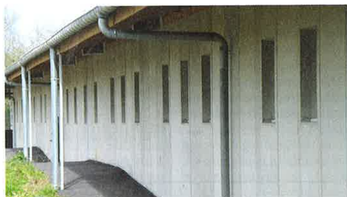
Le couloir extérieur permet aux visiteurs de découvrir les salles de naissance.
