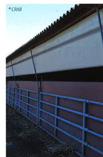
Peu fréquent en élevage de porcs, le rideau brise-vent asservi à une régulation automatique. Le rideau s'abaisse ou se relève en fonction de la température. La consigne est fixée à 18°C en début d'engraissement et à 15°C à la fin. La plage est de 2°C.
