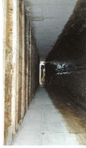
À la bout de chaque couloir de reprise du fumier, une barrière commandée par des vérins hydrauliques stoppe la marche en avant du racler, facilite et sécurise l'évacuation.
